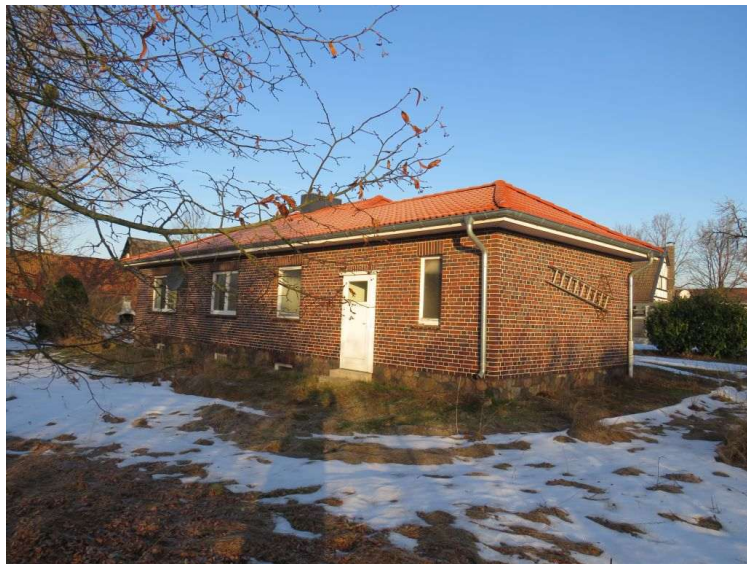
Objektansicht vom Garten
