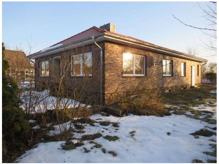
Objektansicht vom Garten
