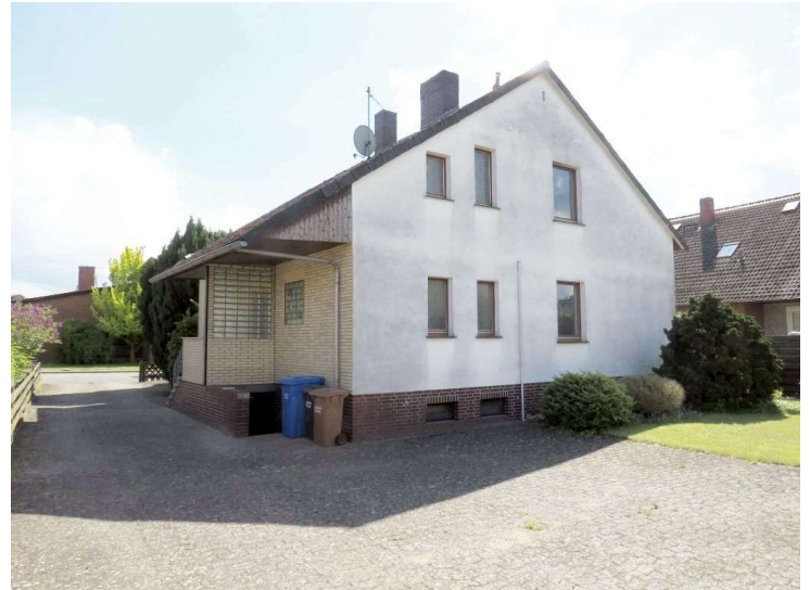
Zufahrt Innenhof und Nordansicht
