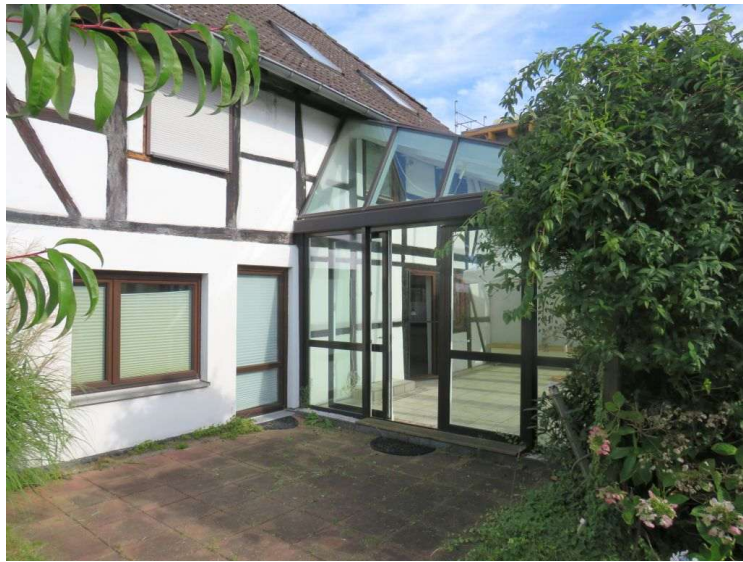
Wintergarten von außen
