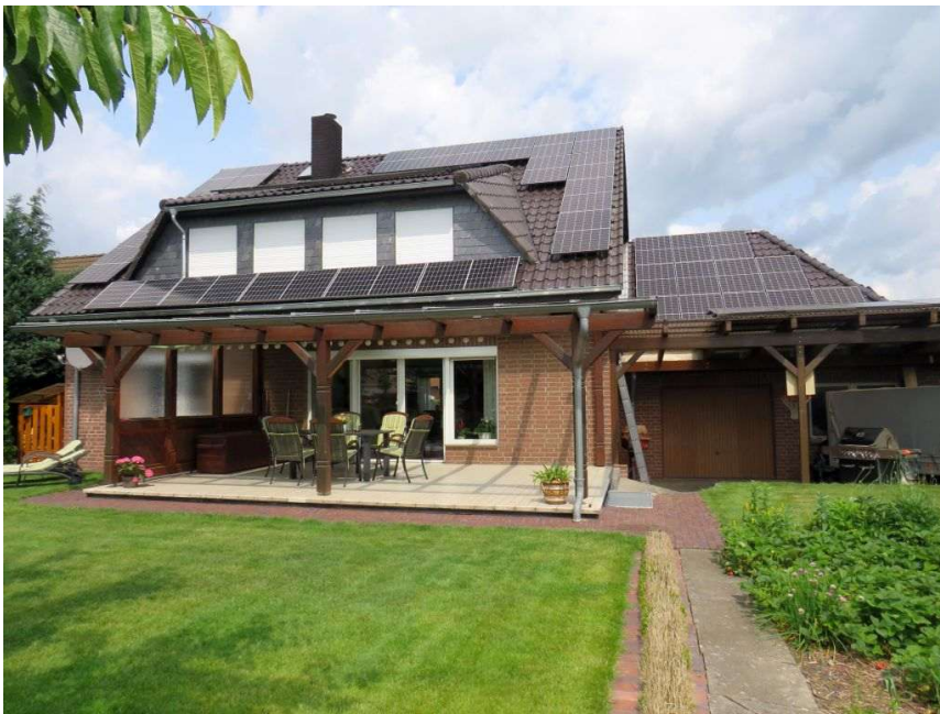
Objektansicht vom Südseite
