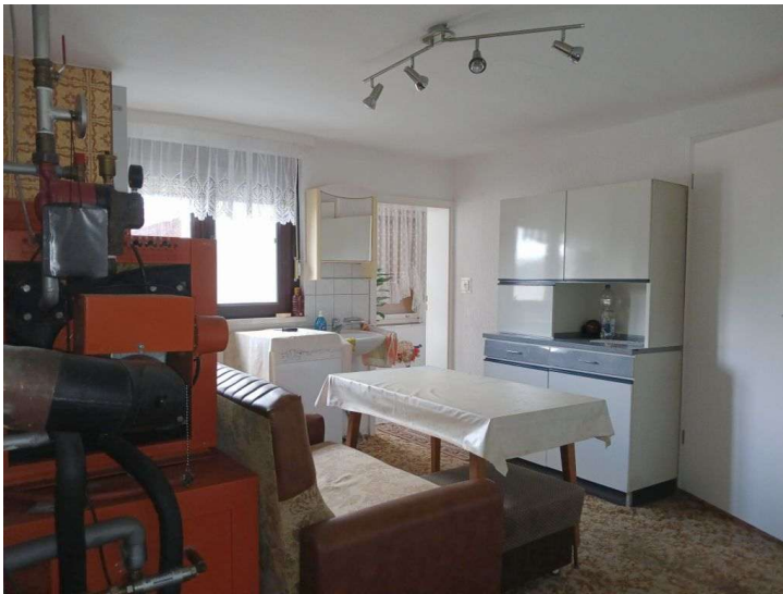
Anschlußraum im EG
