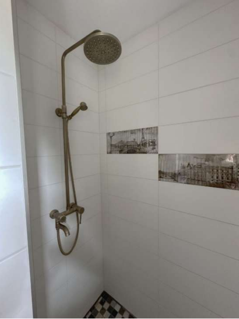
Dusche im Gäste-Bad
