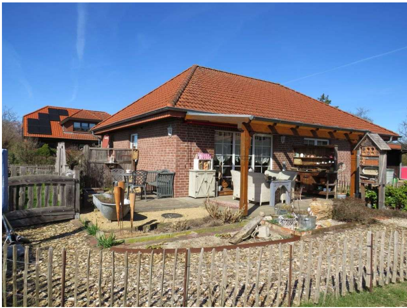
Objektansicht vom Garten
