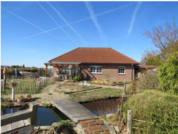
Objektansicht vom Garten
