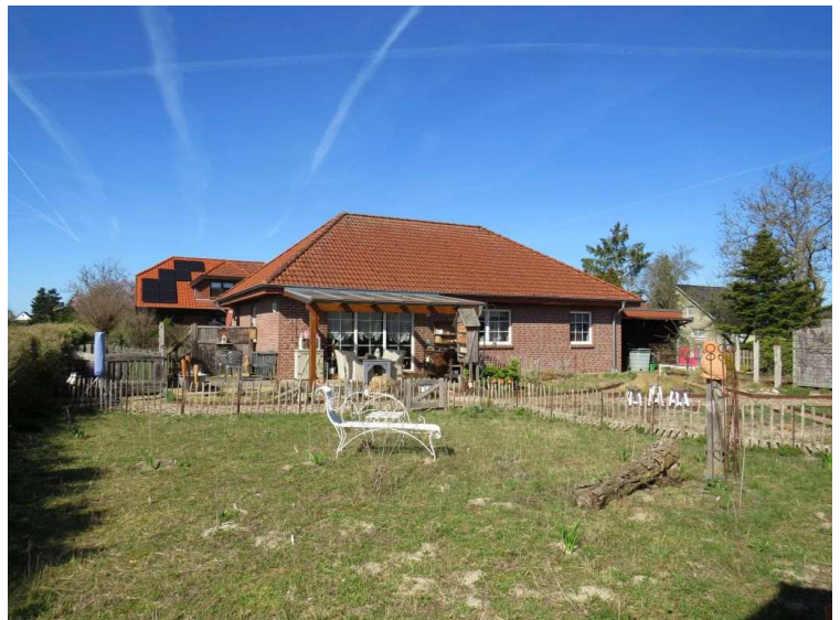
Objektansicht vom Garten
