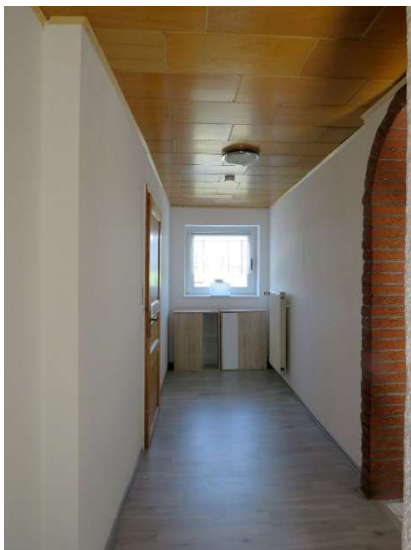
Flur im OG
