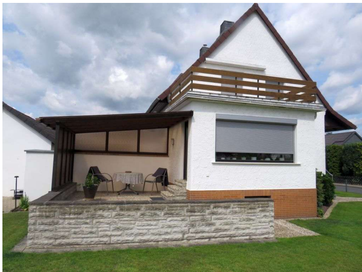
Ostansicht mit Terrasse und Balkon
