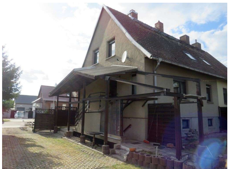
Objektansicht mit Hofeinfahrt
