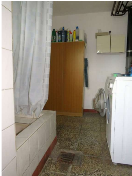
Anschlussraum im Keller
