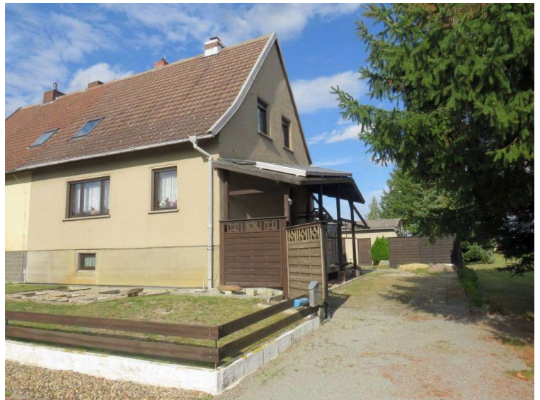
Objektansicht mit Hofeinfahrt
