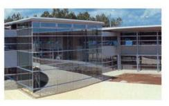
Les composants verriers sont collés à l'aide de mastics qui agissent avant tout comme élément de transfert. Ces mastics jouant le rôle de joint de structure doivent reprendre les efforts engendrés par le vent, le poids propre et les dilatations différentielles entre verre et cadre de support.
