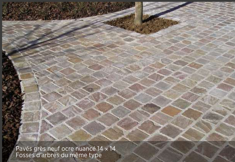
Bordures grès neuf ocre nuancé 15 x 25 x 100 Bateau d'entrée ocre nuancé 15 x 15 x 100 et 14 x 14 x 12 à 14
