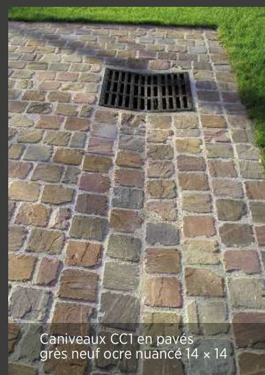
Pavés grès neuf ocre nuancé 14 x 14 - Bordures du même type Caniveaux 30 x 50 x 8
