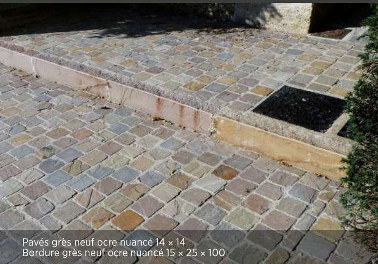
Dessus de marches en pavés grès neuf ocre nuancé 14 x 14 Contre-marches et bordure grès neuf ocre nuancé 8 x 20 x 50
