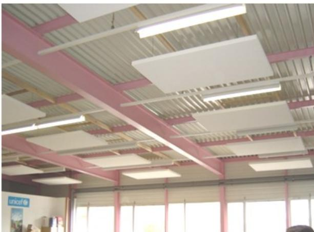
*S'il n'est pas possible de percer dans le plafond, un câble sera tendu entre les rails métalliques et utilisé pour suspendre les panneaux absorbants. Les éléments pourront ainsi être déplacés par ex. pour l'installation d'une nouvelle machine.*
