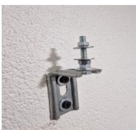
3. Si vous avez un léger décalage de hauteur après avoir fixé les équerres, ce n'est pas grave. Utilisez les écrous de réglage en les vissant ou dévissant afin de positionner le panneau de niveau (voir exemple sur la photo de gauche)
