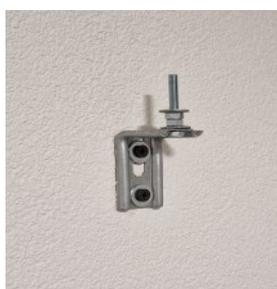
1. Fixer l'équerre au mur, puis visser la vis longue avec 2 écrous sur la partie supérieure de l'équerre. L'écrou supérieur est libre et sert de réglage pour mettre le panneau parfaitement à niveau. Répéter l'opération avec le 2ème équerre. La distance entre les 2 équerres doit correspondre aux trous du rail dans le dos du panneau
