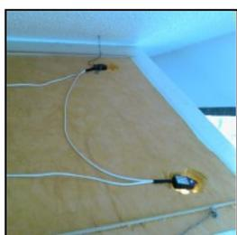
Insérer les spots dans les collerettes, puis procéder aux branchements électriques des spots entre eux lorsque le panneau est encore au sol posé sur les chevalets. Ensuite suspendre le panneau au plafond et procéder au raccordement final à l'alimentation générale. Régler la hauteur finale du panneau et...
