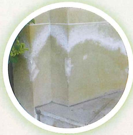
Les bandelettes analytiques **MERCKOQUANT** permettent une évaluation rapide des sels présents dans les murs.
