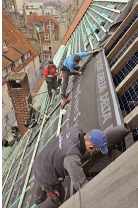
Arbeiten Schritt für Schritt: Rückbau der Altlattung, Verlegung der Unterdeckbahn, Neulattung Fotos (3): Dörken
