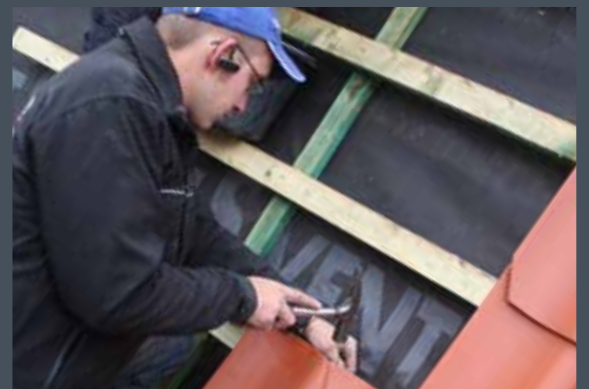
Jeder der 17 000 Hohlziegel wurde mit einer Sturmklammer gesichert Foto: Hans-Jürgen Krolciewicz
