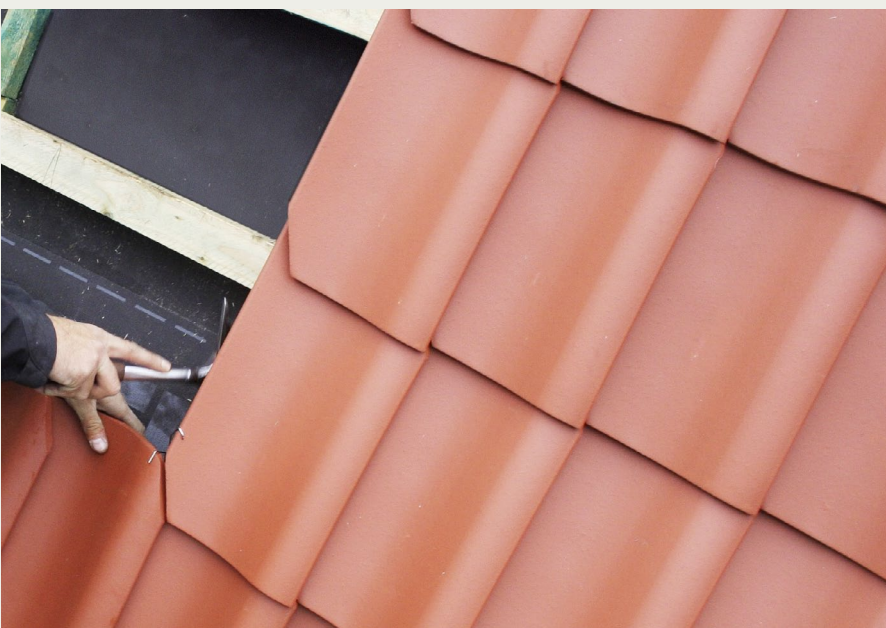
Klammerung im Detail: Der Drahhaken wird in die Latte geschlagen und hält einen Ziegel in der Kopfverfaltung, einen weiteren in der Seitenfalz.
