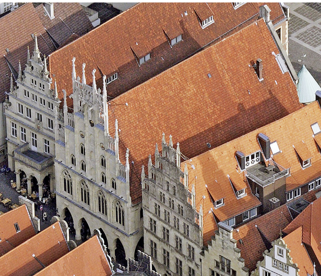
Das Bauvorhaben im Zentrum eines Luftbildes. Hier zeigt sich deutlich die besondere Situation im historischen Umfeld.
