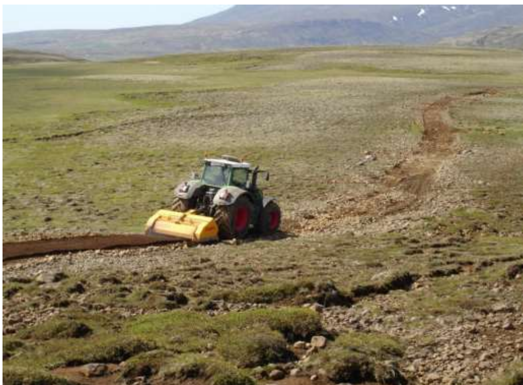
Steinbrjótur við vinnslu á vegstæði á Mosfellsheiði, slík tæki hafa á síðustu árum breytt möguleikum við uppbyggingu reiðvega, Ljósmynd Jóhannes V. Oddsson
