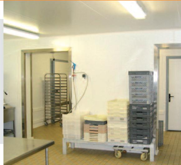
Le panneau isotherme se compose de mousse polyuréthane injectée sans CFC (densité : 45 +/- 5 kg/m<sup>3</sup>) entre un parement de tôles galvanisées laquées blanc.
