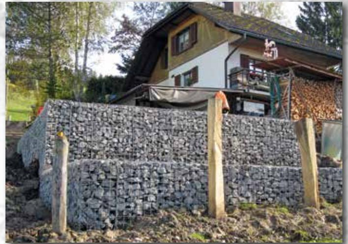
*Stützmauer aus Sytec-Steinkörben*
