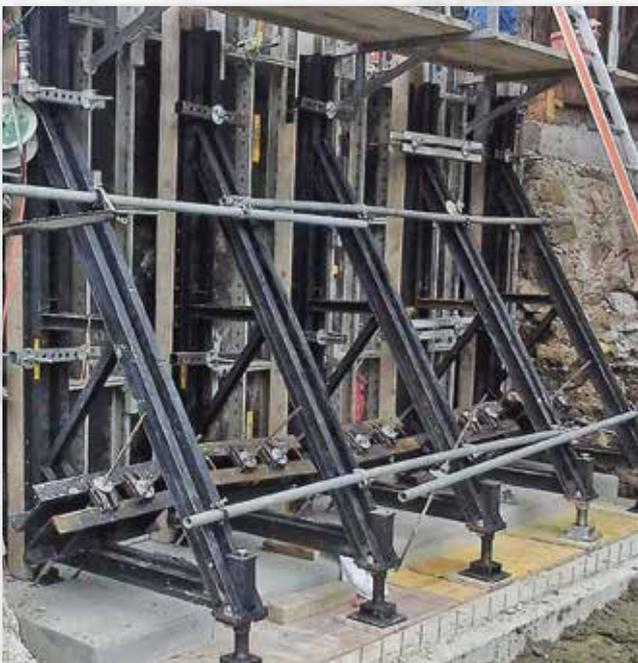
*Vorbetonierung mit Stützbocken*
