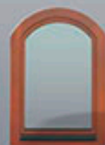
Fenster mit Segmentbogen
