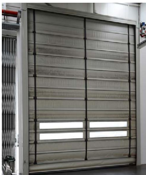
Tela em PVC de enrolar com visores transparentes
