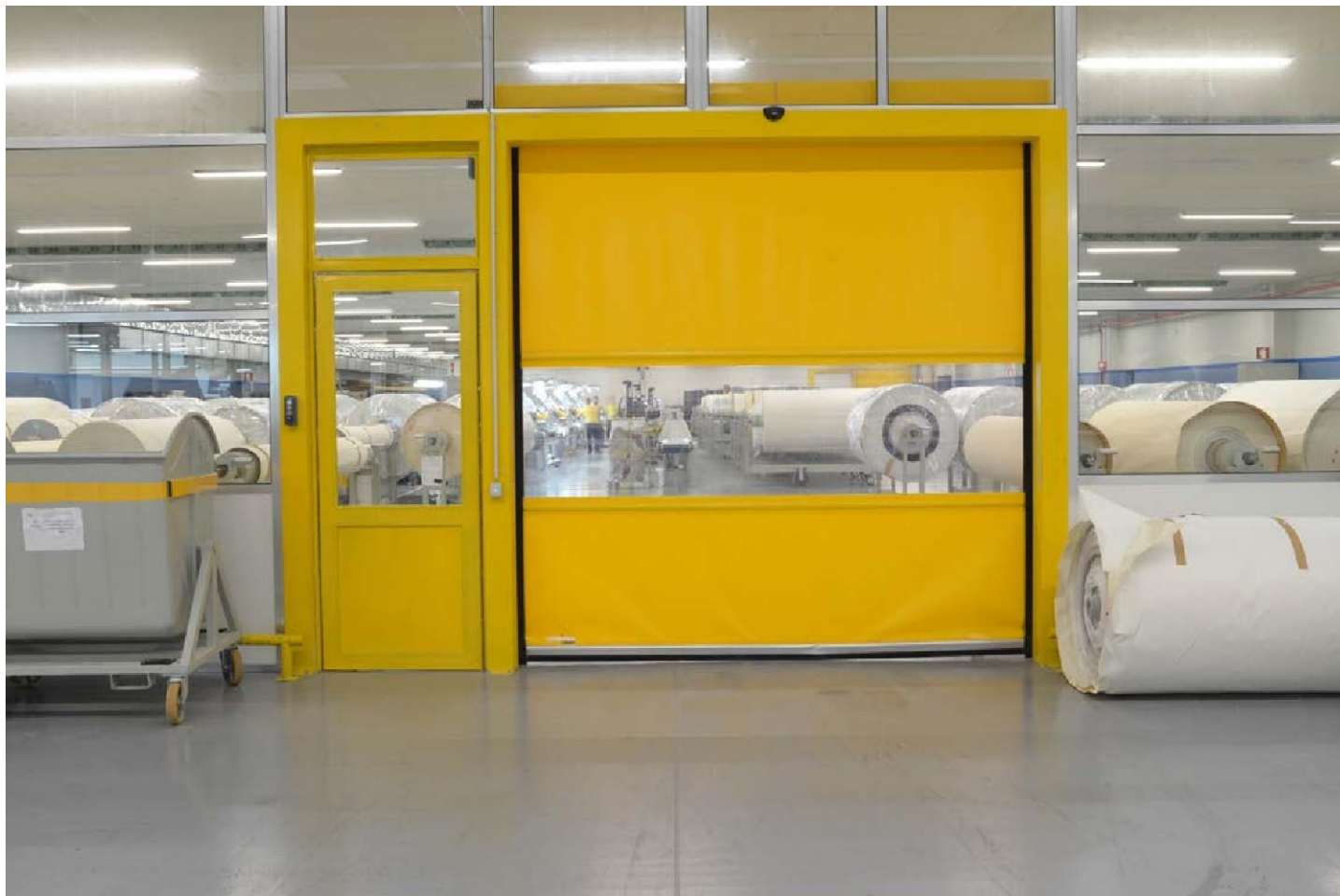
Tela em PVC de enrolar com faixa transparente e porta de serviço lateral
