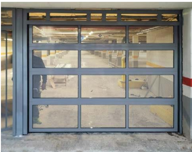
Painel carwy com chapa microperfurada recomendada para zonas com alta necessidade de ventilação
