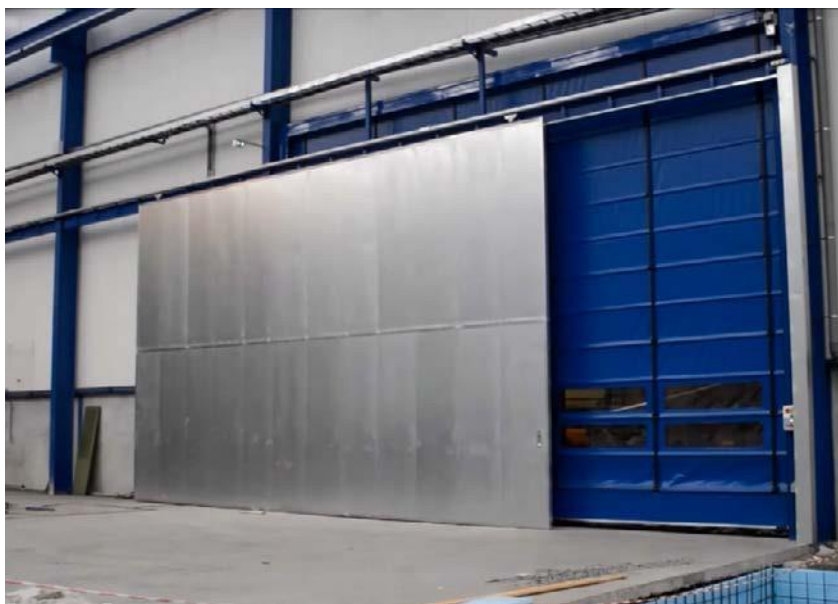
Porta de correr industrial com sistema de fecho por eletroiman e contrapeso
