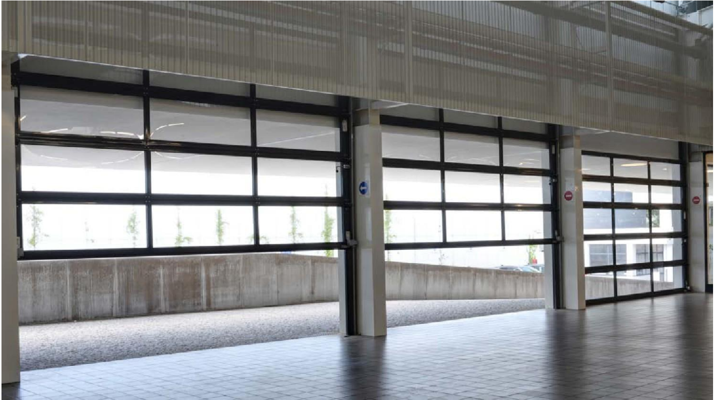
▲ Painel acristalado com acrílico duplo transparente
