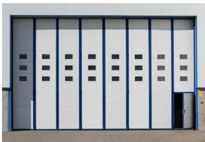
Painel acanelado veteado de uma folha automatizada com porta de serviço, visores com perfilaria de cor diferente do painel e com guia de solo
