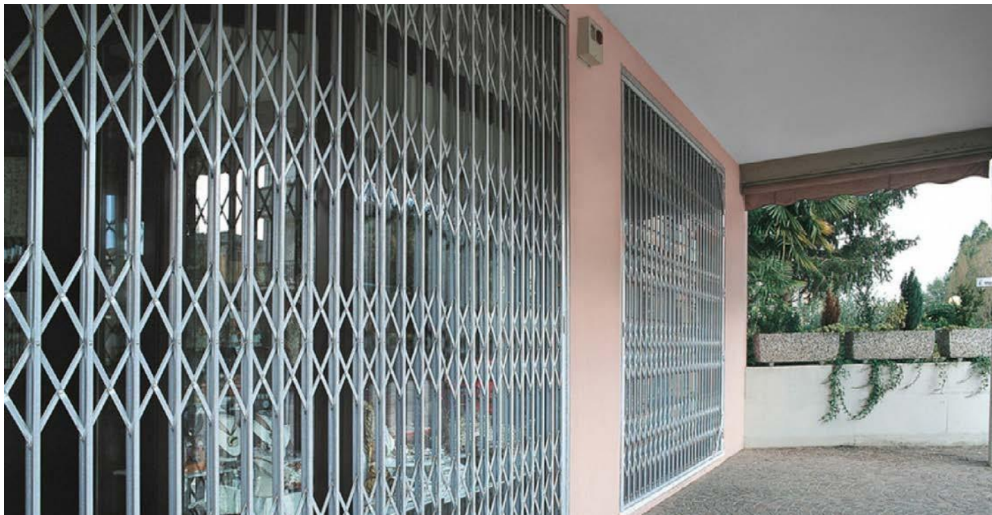
▲ Grade com sistema de rodar e levantar
