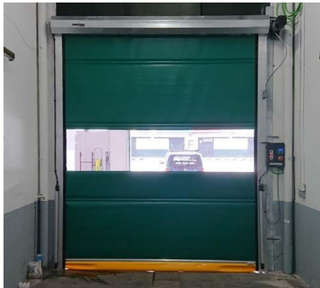
▲ Tela em PVC de enrolar com faixa transparente e acabamentos galvanizados
