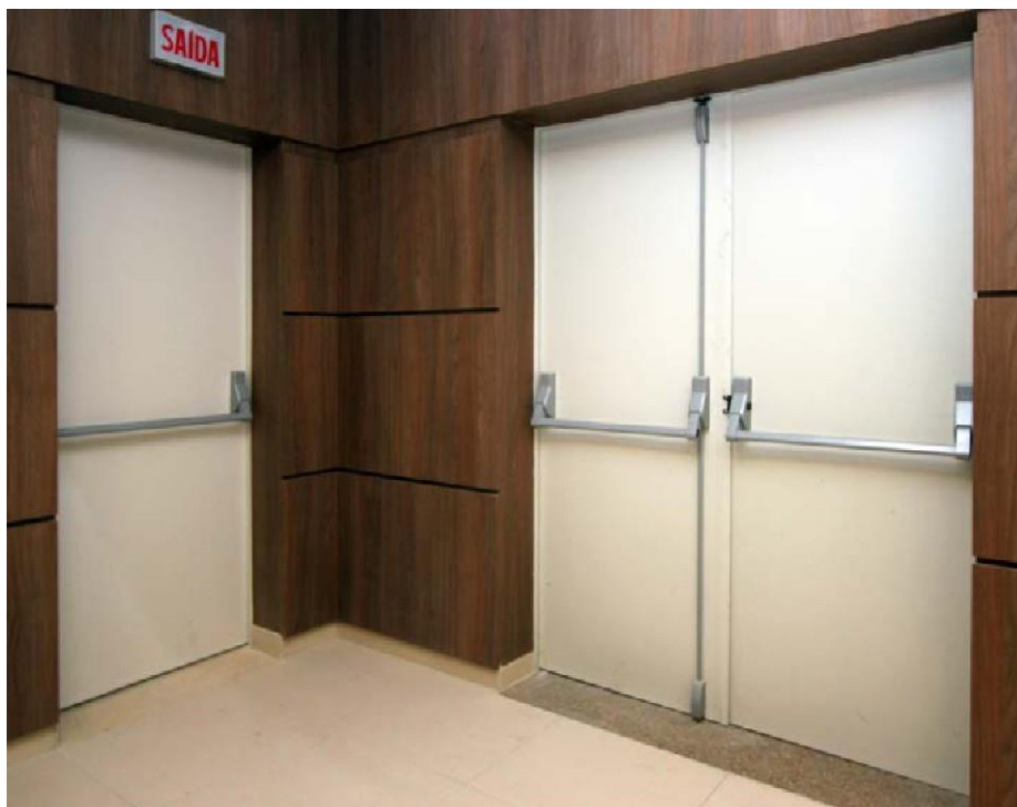
Porta de uma folha e porta de duas folhas com barras anti-pânico simples e dupla
