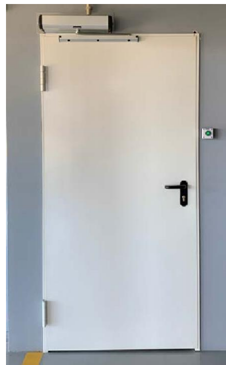
Porta uma folha com teclado/RDIF e kit pedonal de abertura automática com ligação a CDI
