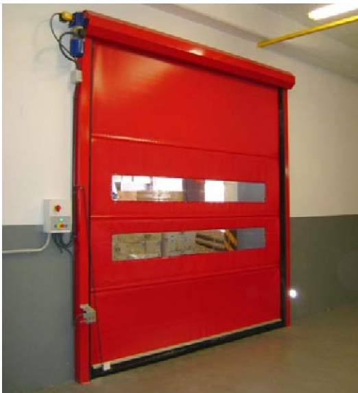
▲ Tela em PVC de enrolar com visores transparentes
