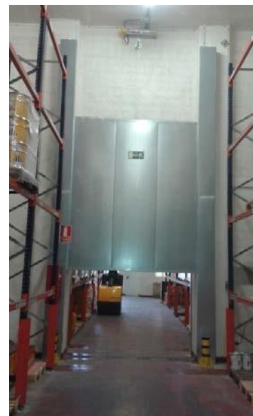
Porta guilhotina de subida vertical com sistema de fecho por eletroiman e contrapeso
