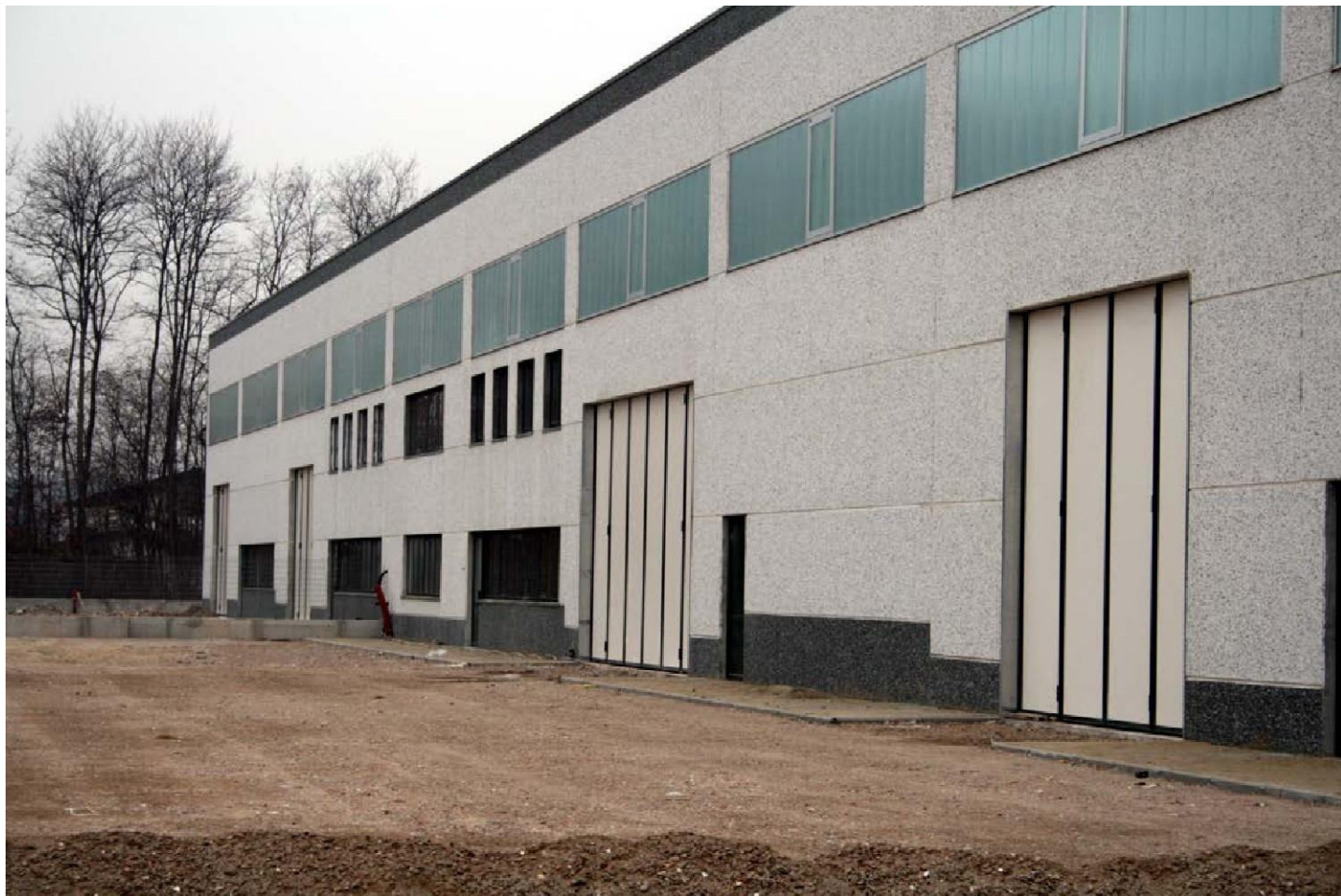
▲ Painel em chapa lisa com guia de solo e abertura manual
